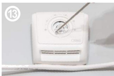
13 Затянуть маленький винт на крышке
