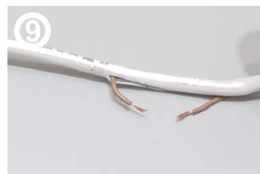
9 Зачистить от изоляции оба конца провода
