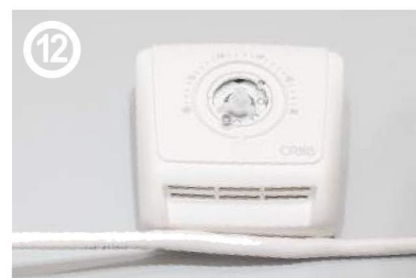
12 Завершив подключение и затянув потуже винты клемм (не перестарайтесь, иначе сорвете резьбу), собрать терморегулятор. Аккуратно установить крышку на место. При необходимости в ней можно сделать надрезы для вывода проводов
