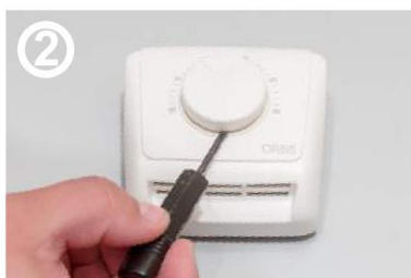
2 Аккуратно поддеть подвижную крышку терморегулятора отверткой и снять её
